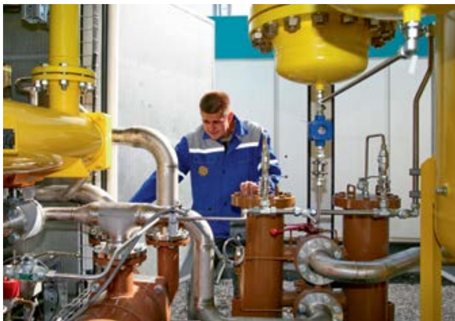
Фото 7. Предпусковые работы на компрессорной станции топливного газа
