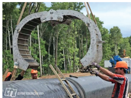
Рис. 1. Использование грейферного индуктора для нагрева сварных стыков перед нанесением ТУМ
